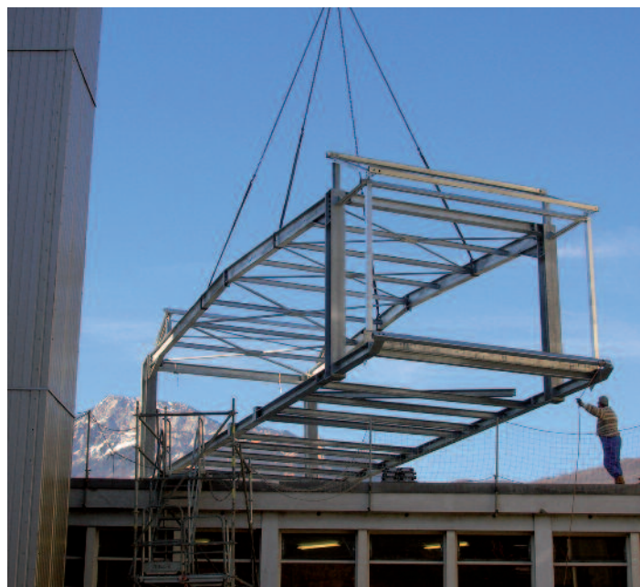
Préfabrication charpente métallique
