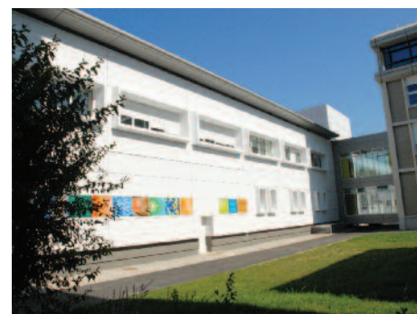
Détail façade ouest bâtiment scientifique Z
