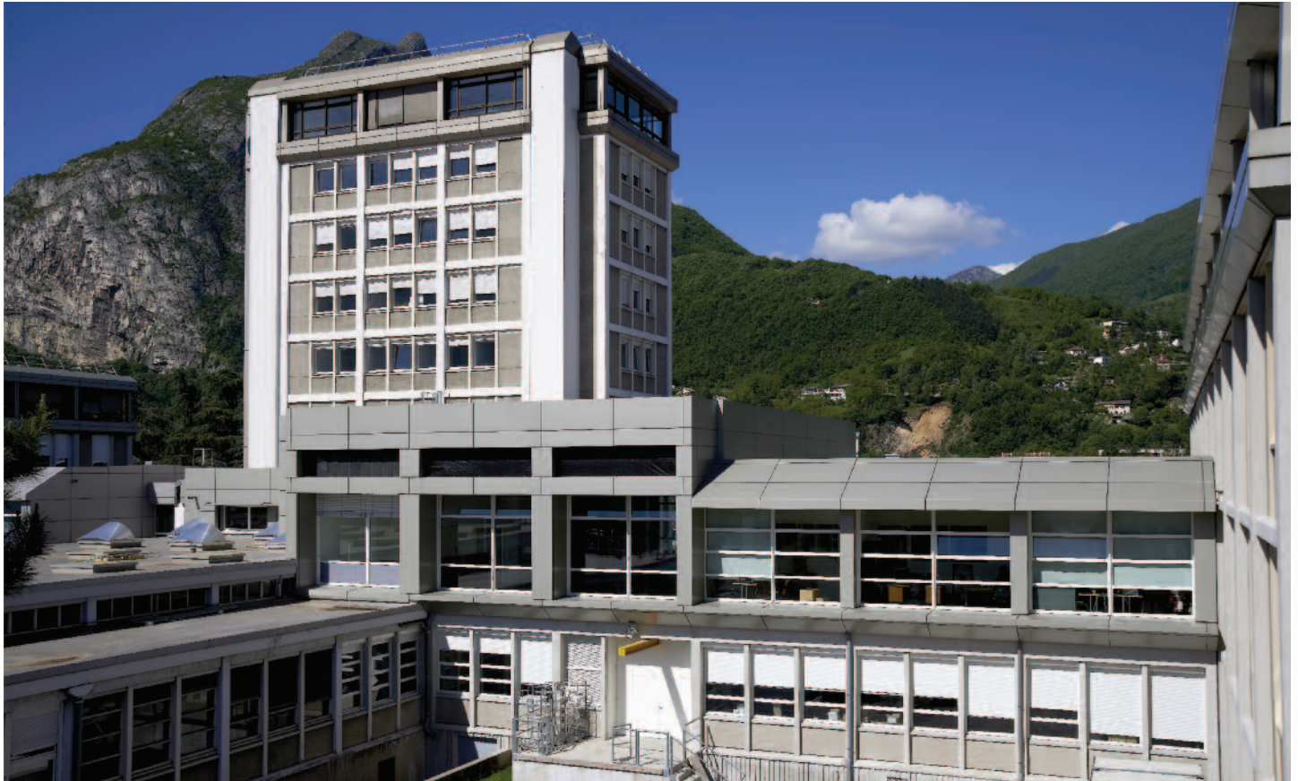
Surélévation / extension du bâtiment C1
