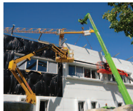
Montage des panneaux en CCV composite
