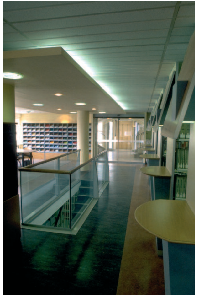
Entrée à porte automatique + compartimentage coupe-feu "invisible"
