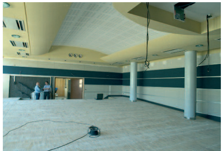
Détail chantier et voûte phonique avec éclairage indirect
