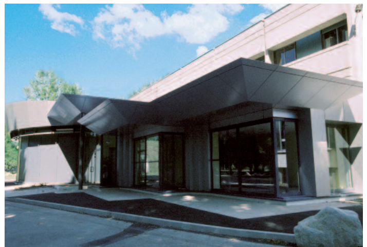
Vue façade sud-ouest
