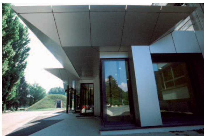
Extension du bâtiment - Façade est
