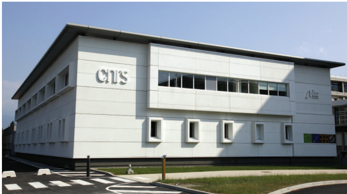
Fronton d'accueil du bâtiment scientifique « Z »
