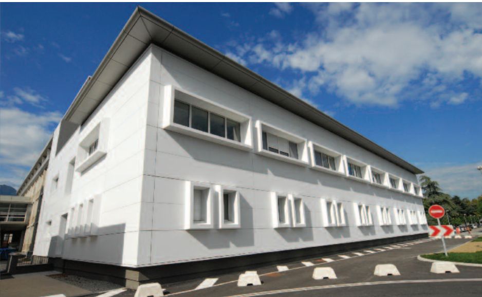
Vue sud-est du bâtiment « Z »
