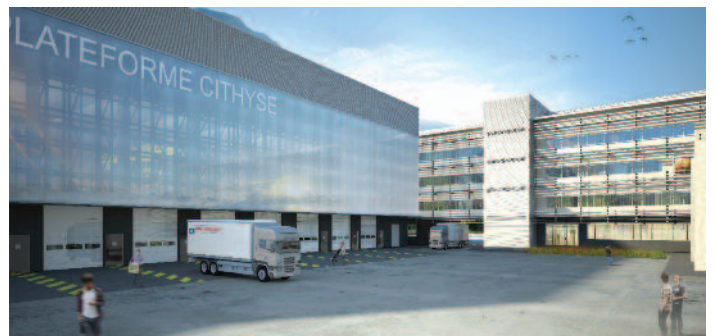
Halle technologique côté cour
