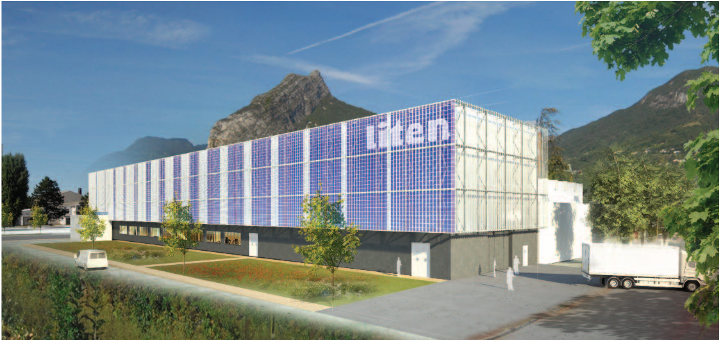
Liten – Halle technologique côté autoroute-CEA-TECH
