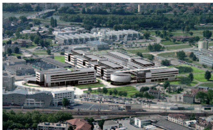
Vue générale site de Minatec/ CEA-Grenoble
