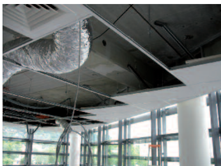
Travaux en cours octobre 2008 - 3 e étage/ Direction
